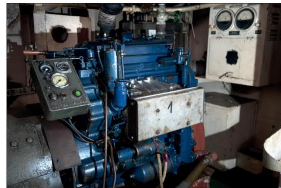
Ein Generator des Schleppers PLANKTON
