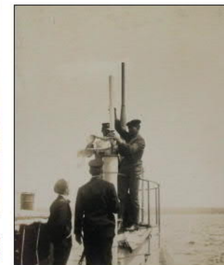
Abb. 4: Montage des dritten Prototyps mit glatter Oberfläche am Flaggenstock von U 1
