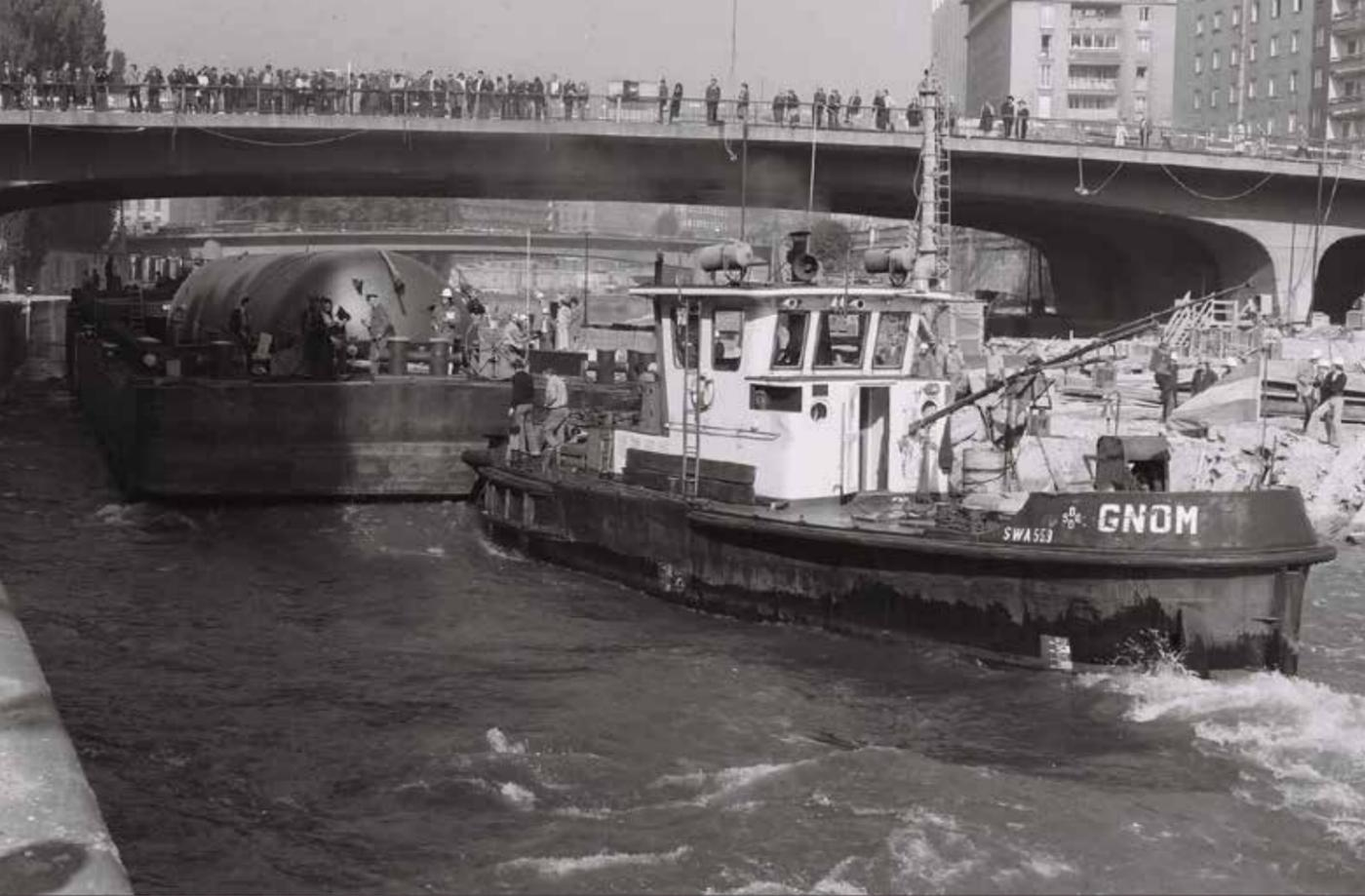
*GNOM dockt an einem DDSG-Leichter, beladen mit einem Schwergut-Druckbehälter, im Bereich der Baustelle U1, Schwedenplatz, an.*
