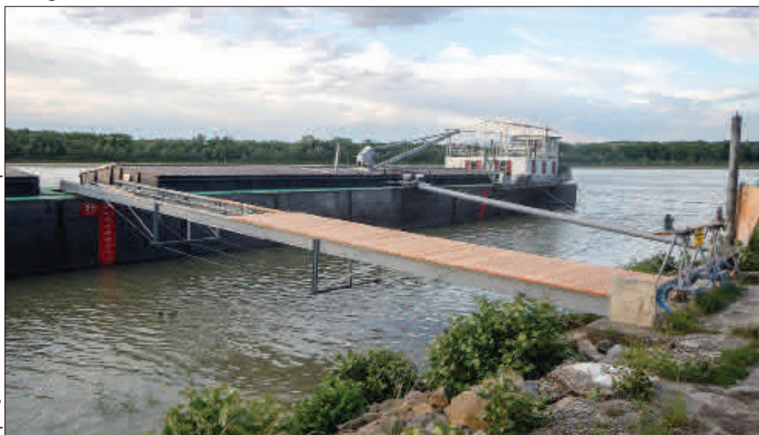
Bauarbeiten am Stegladen.
