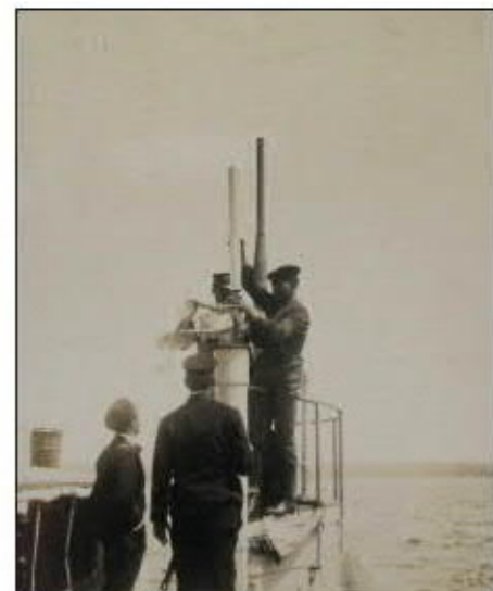
Abb. 4: Montage des dritten Prototyps mit glatter Oberfläche am Flaggenstock von U 1
